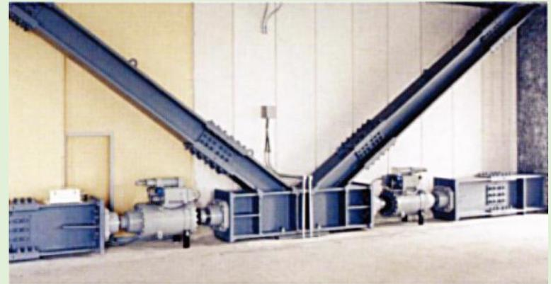
制震装置HiDAXの施工例
