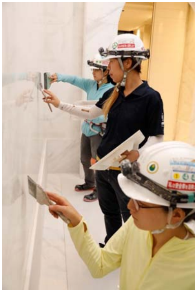
Cap③) ラウンジ壁面の特殊塗装は技術とともに感性が求められる繊細な作業(左)。地下駐車場の一角に「練習場」を設け、カーブの表現や塗料の濃度を検討しながら特訓した。施主や設計部門ともその場に立ち会い精度を確認できた。竹延社長は「早めに材料と工程を決めていただけたので、技術に習熟する時間をとることができた」と話す。
