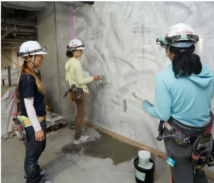
Cap③) ラウンジ壁面の特殊塗装は技術とともに感性が求められる繊細な作業(左)。地下駐車場の一角に「練習場」を設け、カーブの表現や塗料の濃度を検討しながら特訓した。施主や設計部門ともその場に立ち会い精度を確認できた。竹延社長は「早めに材料と工程を決めていただけたので、技術に習熟する時間をとることができた」と話す。
